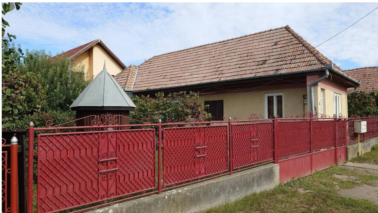
Casă, sat Nazna, strada Principală, nr. 176
