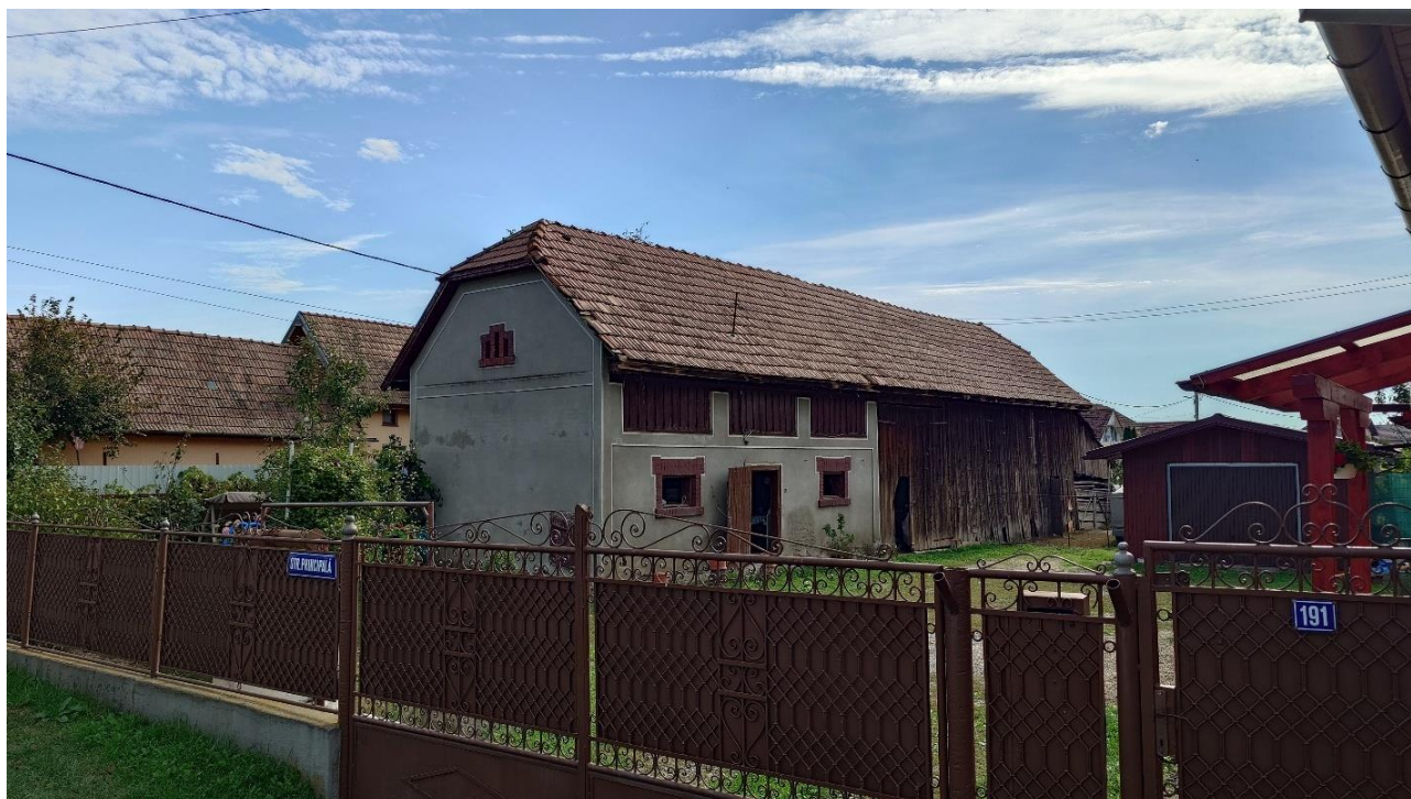
Șură, sat Nazna, strada Principală, nr. 191
