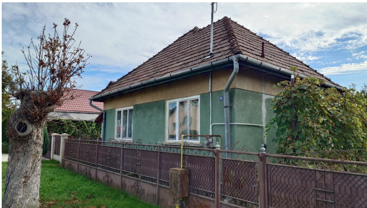
Casă, sat Nazna, strada Principală, nr. 165
