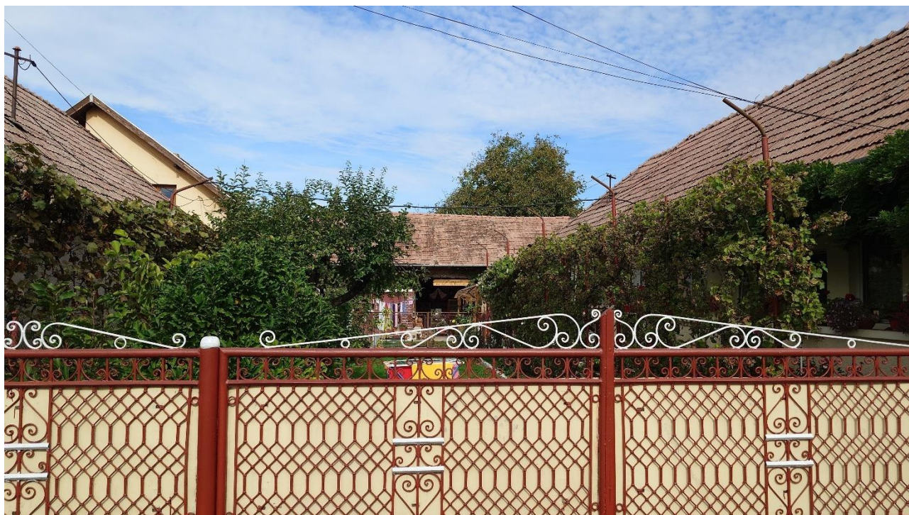
Casă și șură, sat Nazna, strada Principală, nr. 174
