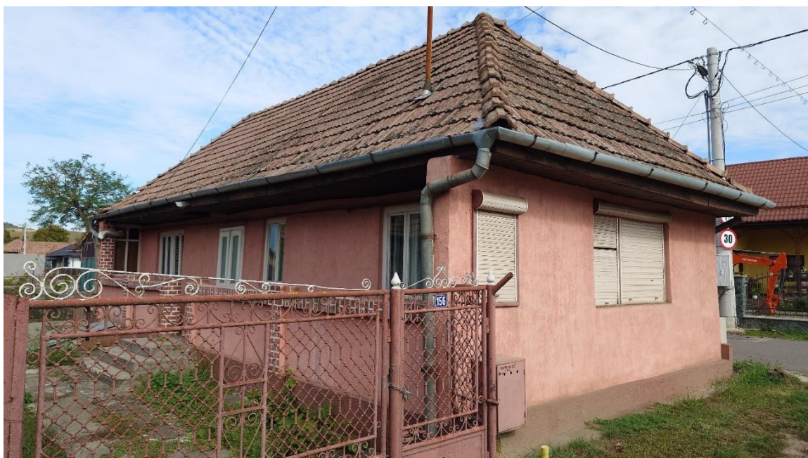
Casă, sat Nazna, strada Principală, nr. 156
